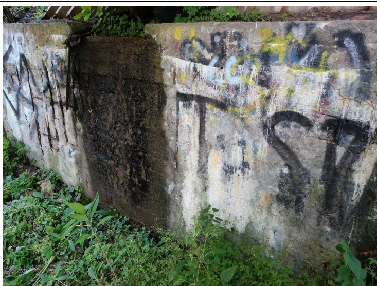
Foto č. 3 Opěra O 02 – průsak vody a pojiva, vydrolené zdivo, koroze výztuže
