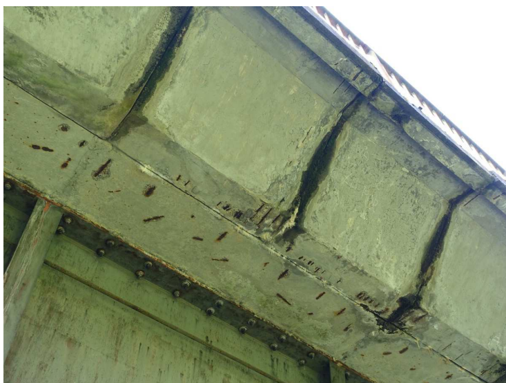
Foto č. 1 Konstrukce K 01 – čelní strana vlevo – průsak vody a pojiva
